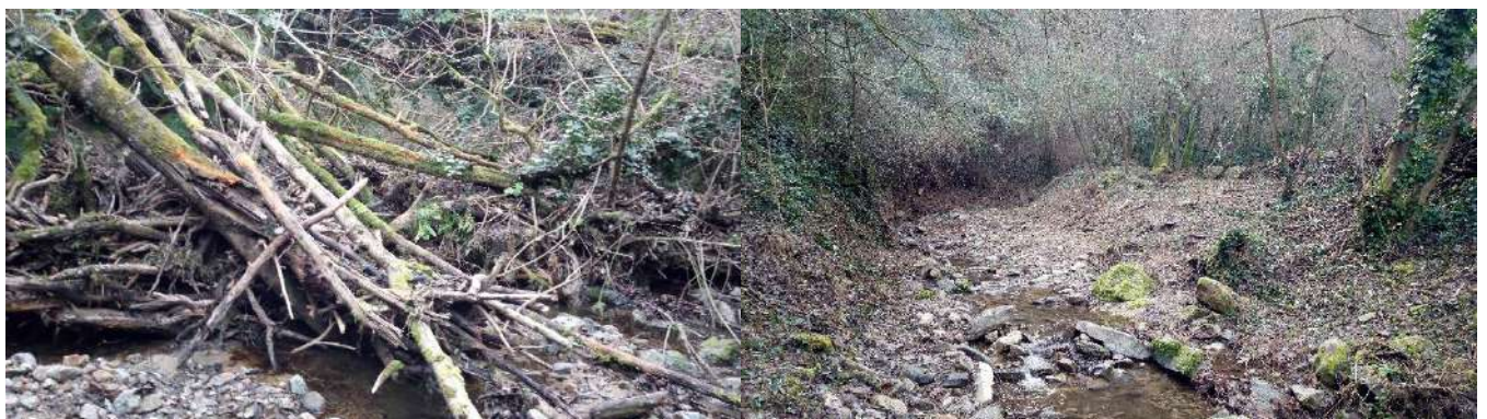
Ruisseau du Berthier avant et après travaux
