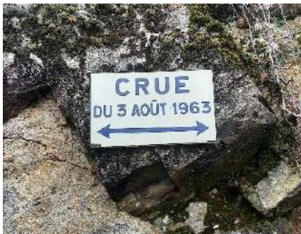
Bon état à Retourtour (Lamastre)
