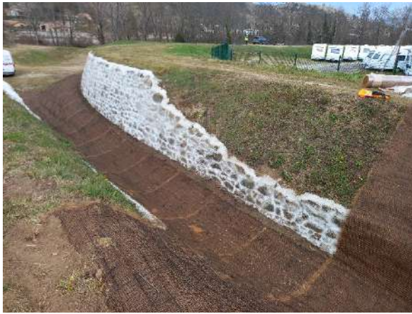
Rejointement et pose de la géogrille
