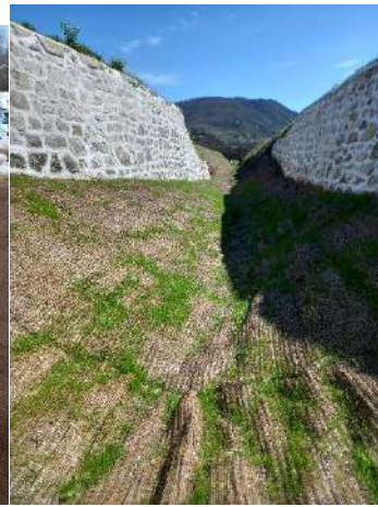
Reprise végétative sur la géogrille
